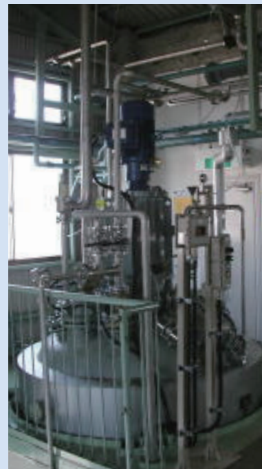
5000L GL加圧反応缶
